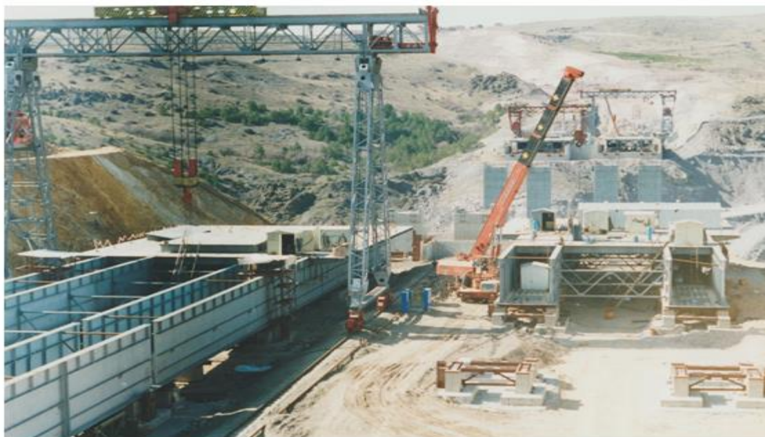
Рис. 1. Монтаж пролетных строений моста на стапельных площадках Fig. 1. Installation of bridge spans on slipways
