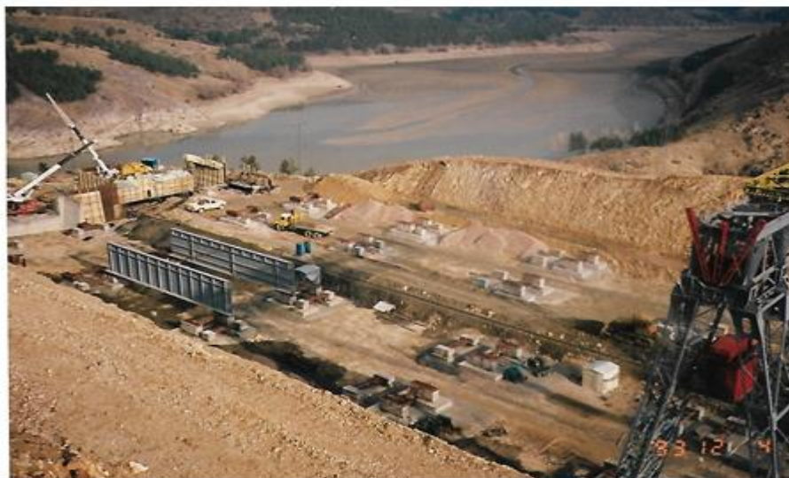
Рис. 2. Начало монтажа пролета (блока) на стапельной площадке. Fig. 2. Start of installation of the span (block) on the slipway platform.
