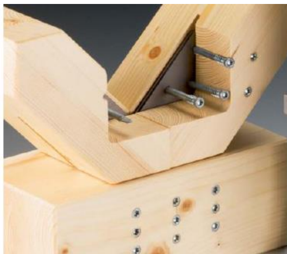
Рисунок 4. Соединения деревянных конструкций с использованием самонарезающих нагелей
