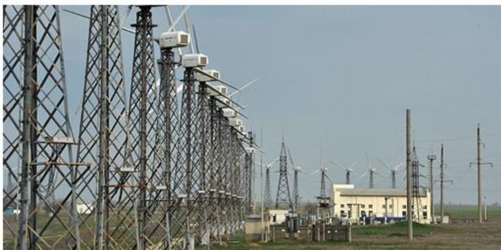
Рисунок 2 - Мирновская ветряная электростанция в Крыму
