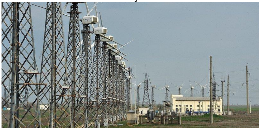
Рисунок 2 - Мирновская ветряная электростанция в Крыму
